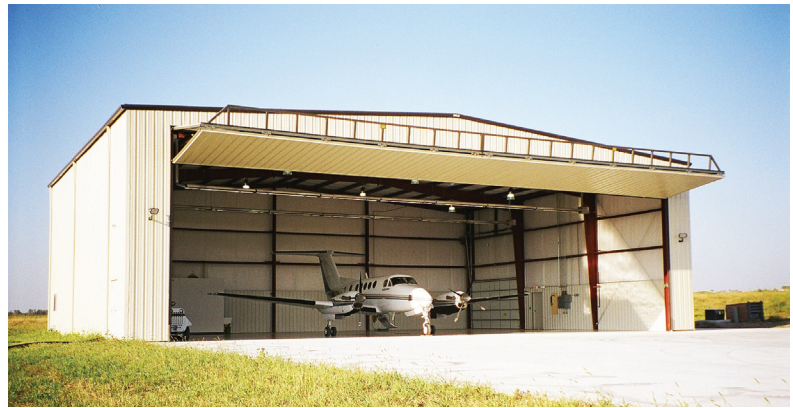
Linweld Hangar - Lincoln, NE
