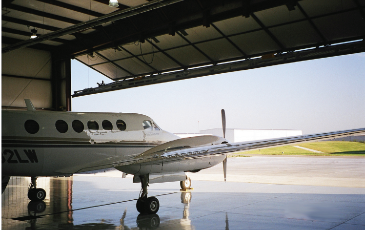
Linweld Hangar - Lincoln, NE
